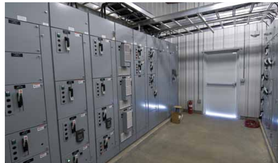
Heatec a également fourni et construit le centre de contrôle des moteurs pour la nouvelle usine d'émulsion. Photo: Gracieuseté de Heatec.
